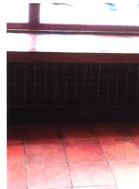
II. 123 Lokal d. baru Szanghaj, ob., siedziba biblioteki, przed remontem, parter, kratka zabezpieczająca pod witryną okienną, fot. MWKZ, 2018
