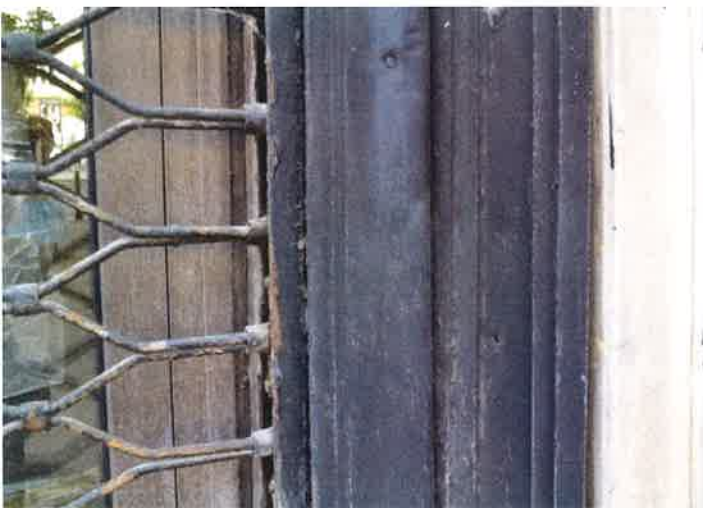
II. 104-105 Historyczna rolowana krata witryn okiennych z profilowaną metalową listwą maskującą
