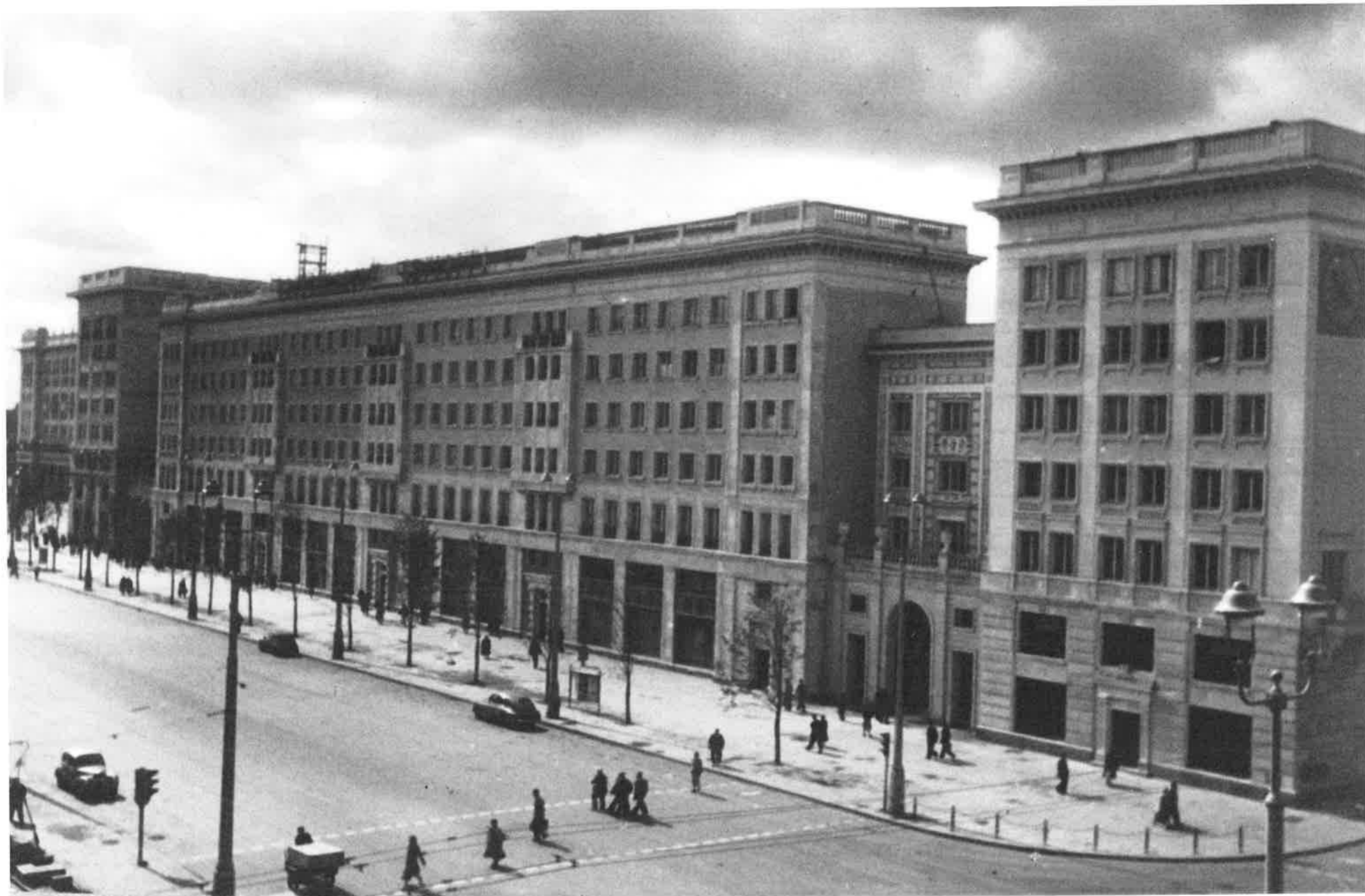
II. 13 Budynek przy ul. Marszałkowskiej 55/73, elewacja frontowa, widok w kierunku pl. Konstytucji, fot. ok. 1952, F. Falkowski, ze zbiorów Archiwum Fotograficznego Instytutu Sztuki PAN
