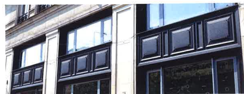
II. 113 Odtworzone płyciny miedzy witrynami parteru i antresoli w d. barze mięsny - bibliotece
