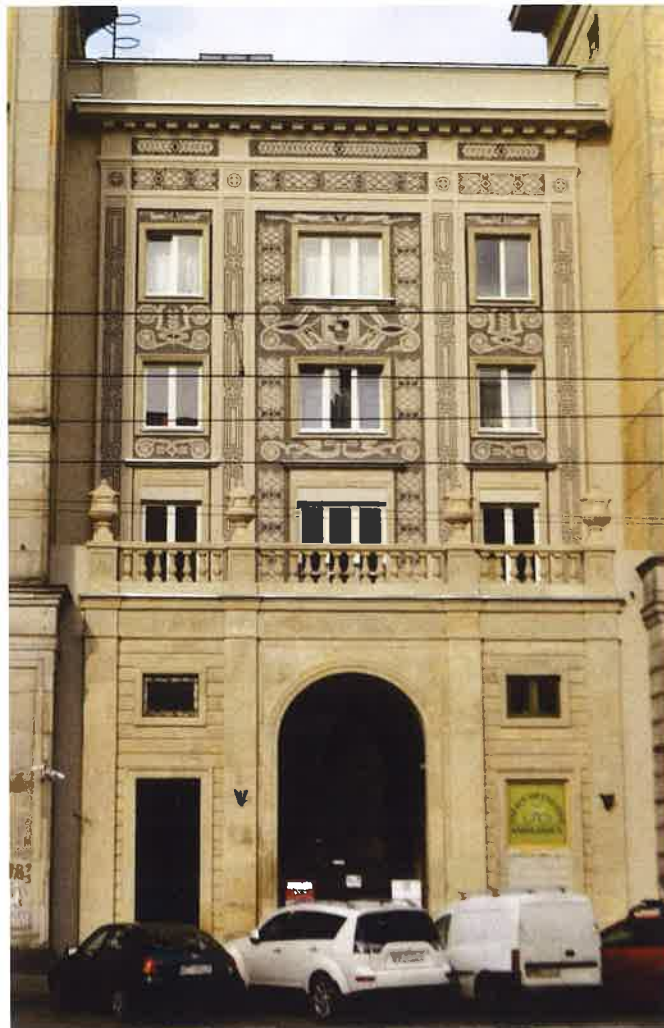
II. 64 Elewacja frontowa, łącznik północny (częściowo zabudowany)
