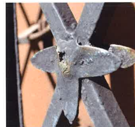
II. 107-108 Detal stałej kraty okiennej od strony podwórka
