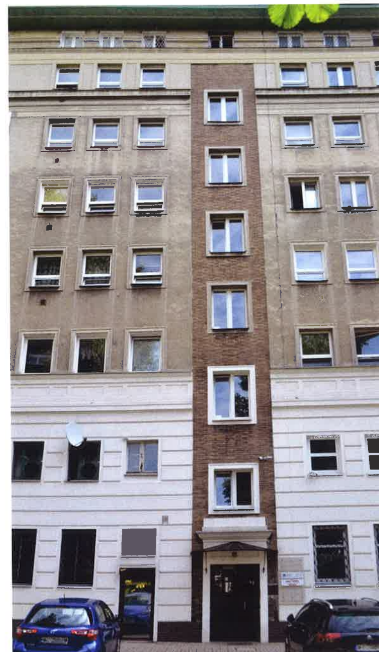
II. 53 Elewacja od strony podwórka pion klatki schodowej z klinkieru
