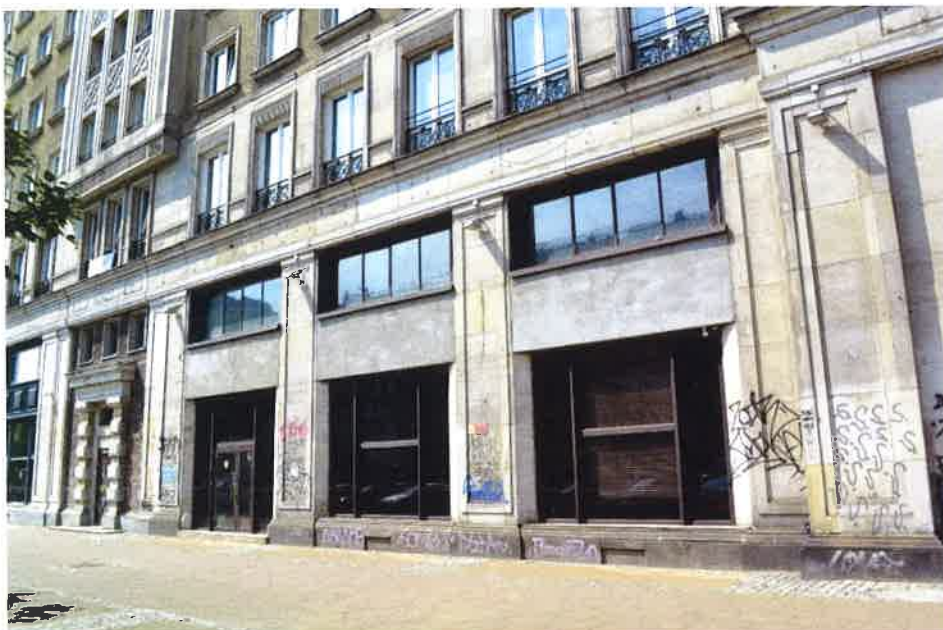
Il. 43 Elewacja frontowa, witryna lokalu użytkowego (d. bar rybny; „Flis”), nieużytkowany
