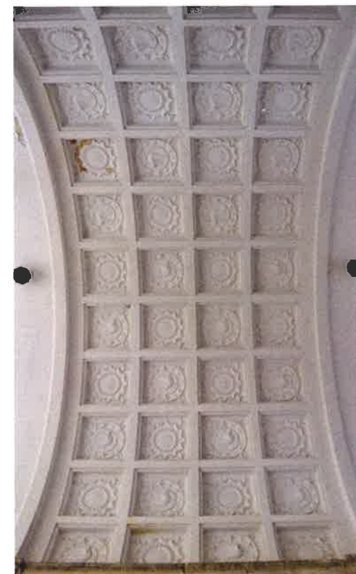
II. 73 Łącznik południowy, widok na środkowe przęsło z pomalowanymi na biało kasetonami ceramicznymi
