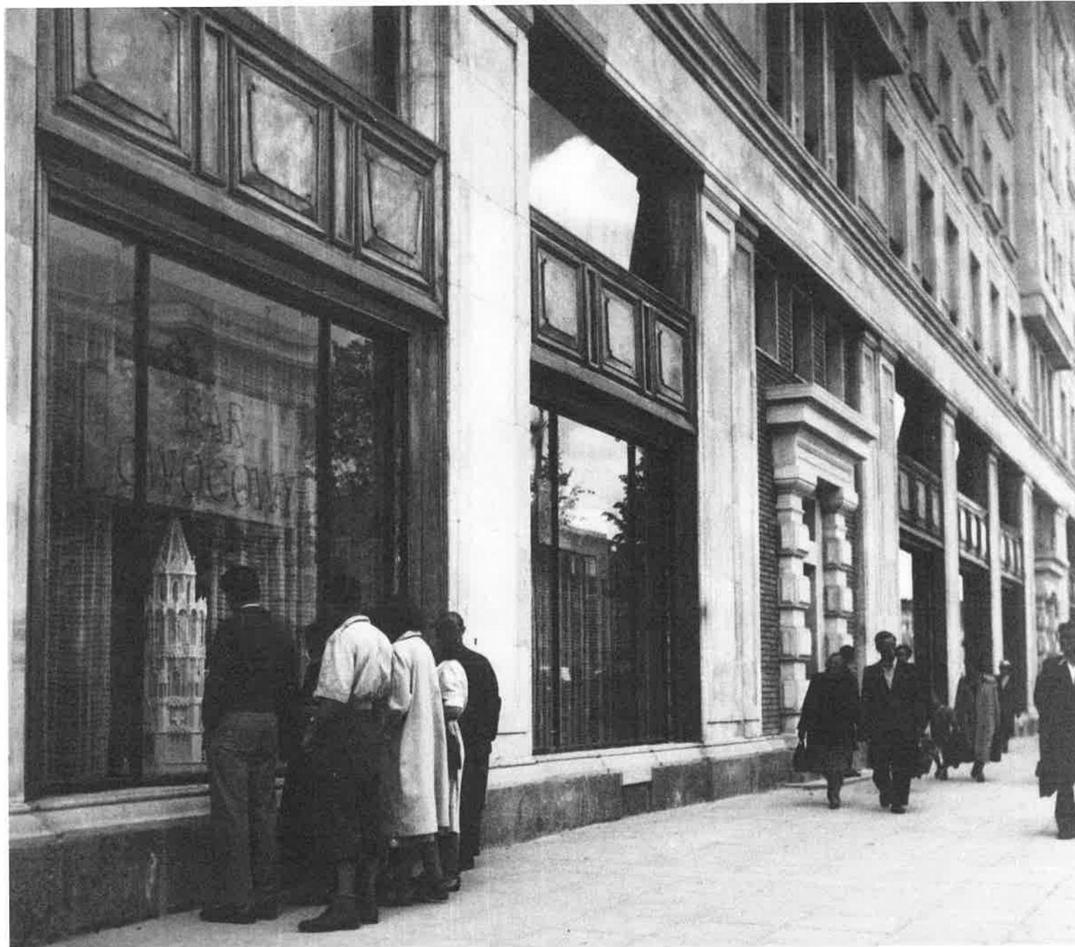
II. 15 Budynek przy ul. Marszałkowskiej 55/73, elewacja frontowa, widok witryny baru owocowego, widoczna ekspozycja, okładzina ceramiczna obokni, fot. ok. 1952, W. Piotrowski, ze zbiorów Archiwum Fotograficznego Instytutu Sztuki PAN
