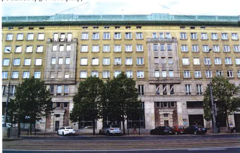
II. 41 Elewacja frontowa, widok w kierunku zachodnim, w przyziemiu wejścia do lokali, powyżej wykusze
