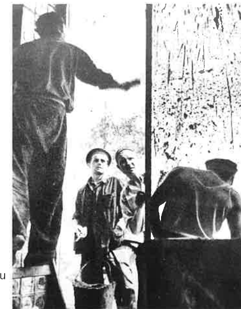
Il. 9 Prace porządkowe w lokalu użytkowym na MDM-ie, po lewej stronie widoczna okładzina z płytek ceramicznych, fot. 1952, E. Hartwig, repr. MDM, Janowski, 1955
