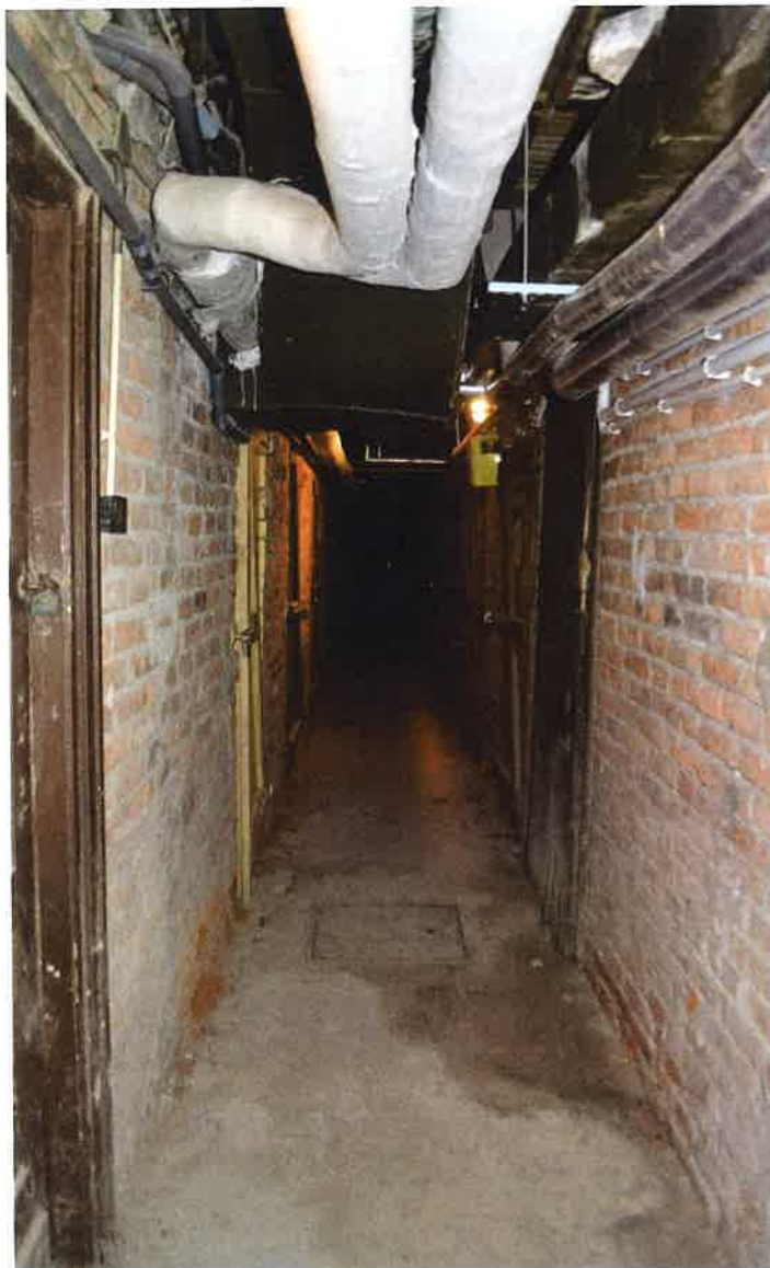
II. 101 Korytarz w piwnicy budynku, posadzka cementowa, ściany ceglane, instalacje prowadzone podsufitowo
