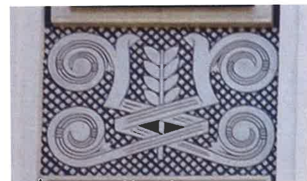
II. 70 Sgraffitowa dekoracja płycin podokiennych północnego łącznika
