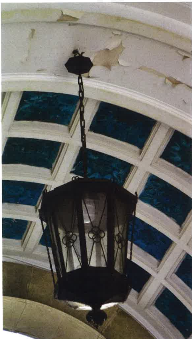
II. 109 Oryginalna latarnia w północnym łączniku w środkowej nawie
