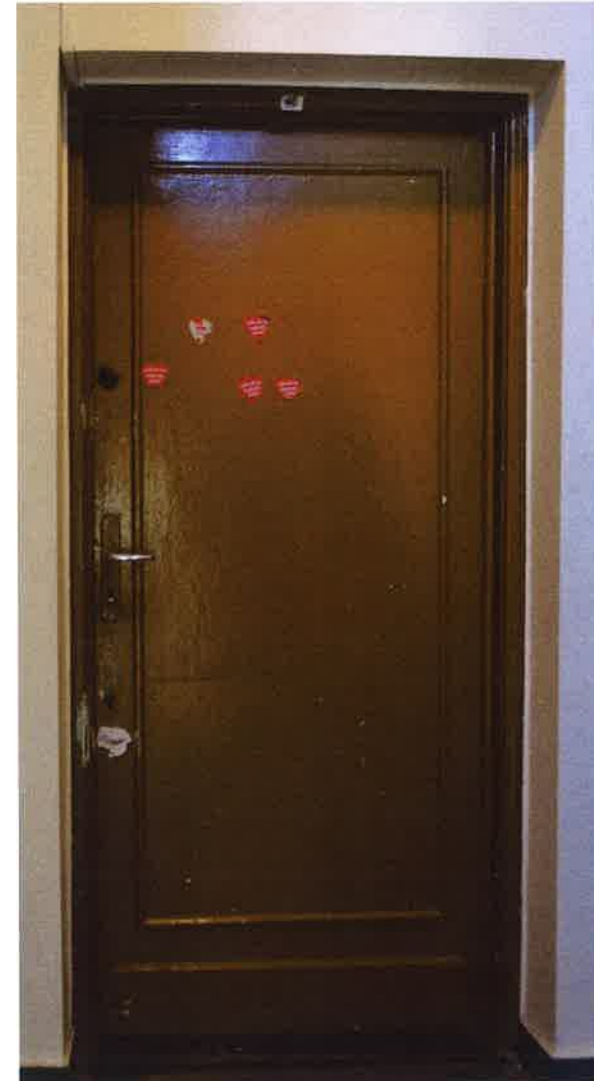
II. 100 Oryginalne drzwi wejściowe do lokalu
