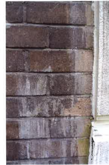
Il. 57 Detal elewacji od strony podwórka okładzina klinkierowa i opracowanie ściany w tynku
