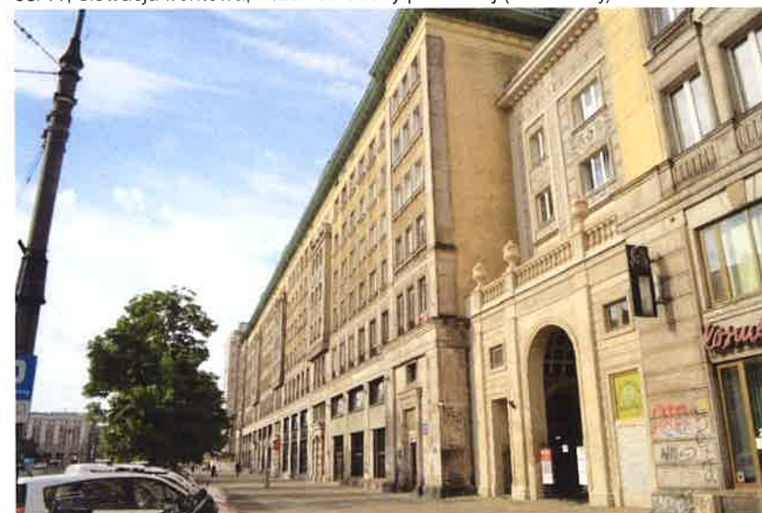
II. 42 Elewacja frontowa, widok od strony północnej na łącznik i ścianę szczytową
