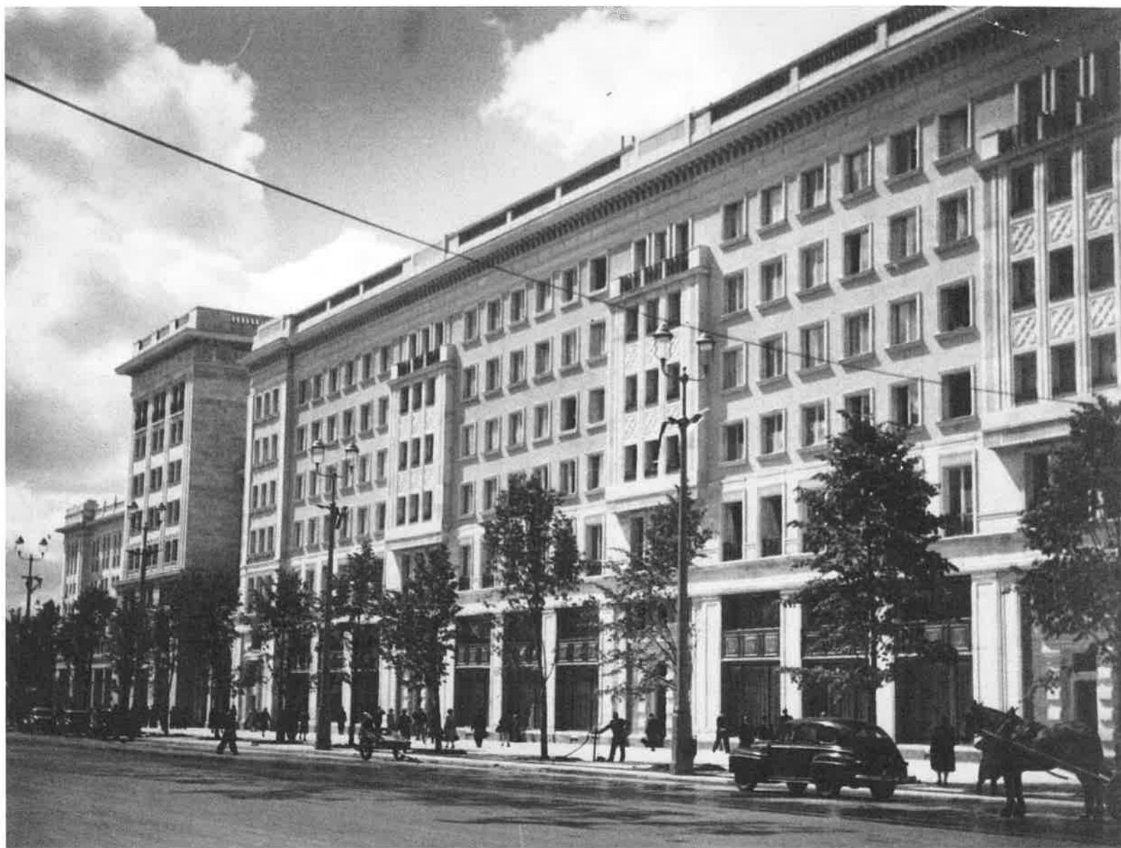
Il. 14 Budynek przy ul. Marszałkowskiej 55/73, elewacja frontowa, widok w kierunku pl. Konstytucji, fot. ok. 1952, F. Myszkowski, ze zbiorów Archiwum Fotograficznego Instytutu Sztuki PAN
