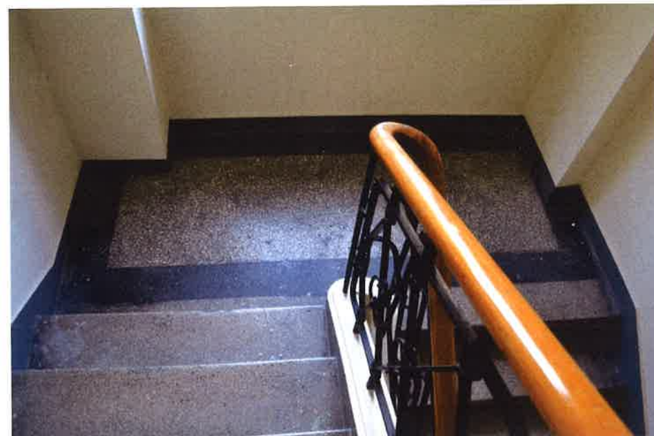
II. 93 Wnętrze klatki schodowej, posadzka z lastryko na półpiętrze
