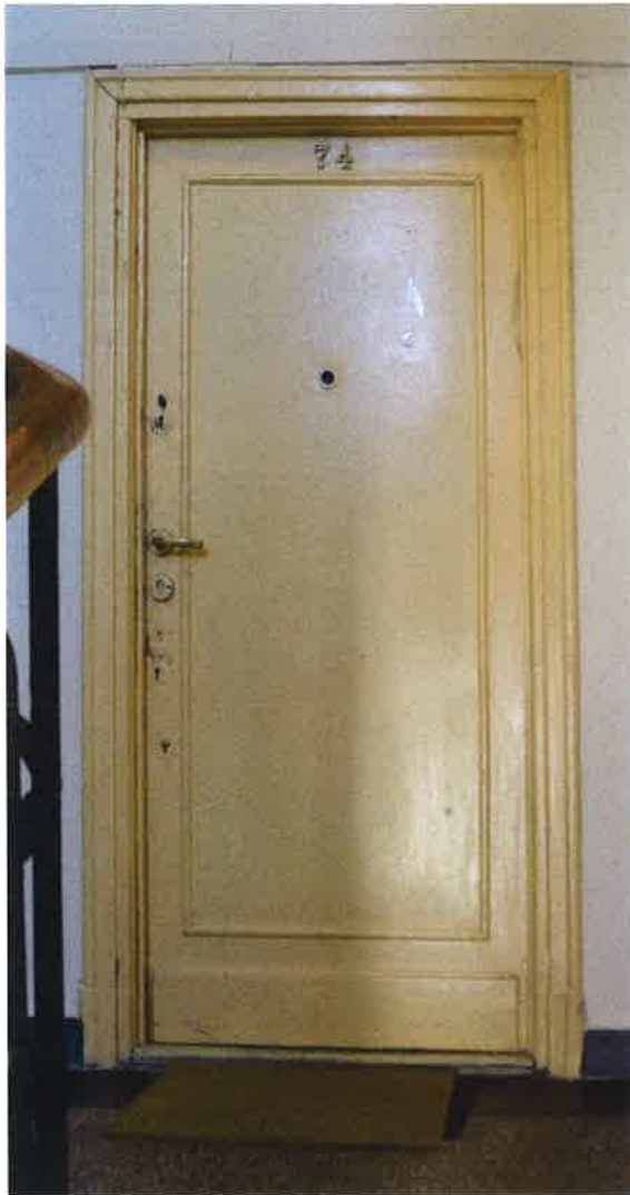
II. 98 Oryginalne drzwi wejściowe do lokalu mieszkalnego z profilowanymi odzwiami
