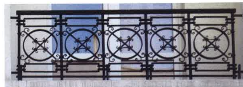
II. 112 Oryginalna balustrada loggi z powtarzalnych przęseł metalowych
