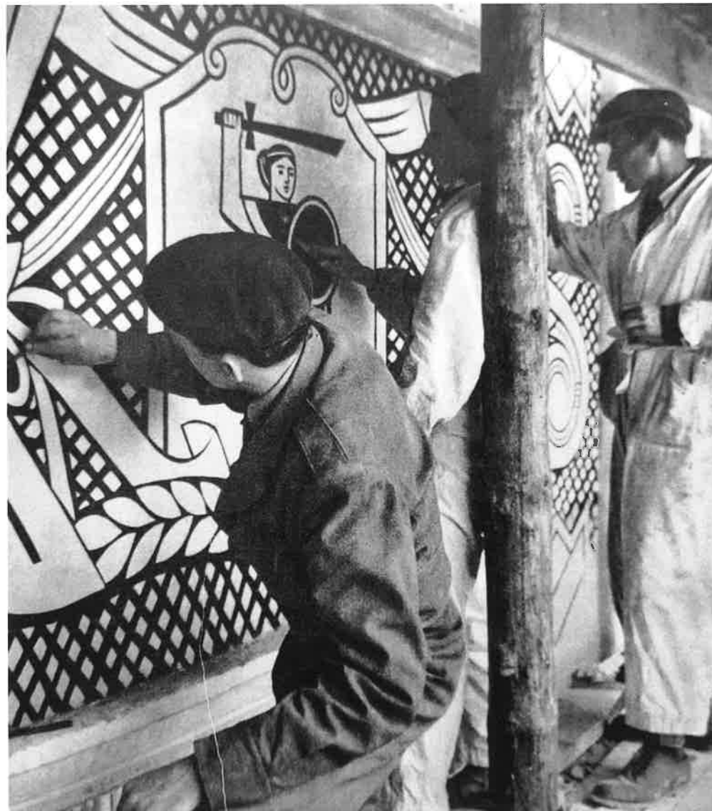
Il. 23 Prace przy sgraffito na elewacji, fot. 1952, E. Hartwig, repr. MDM, Janowski, 1955
