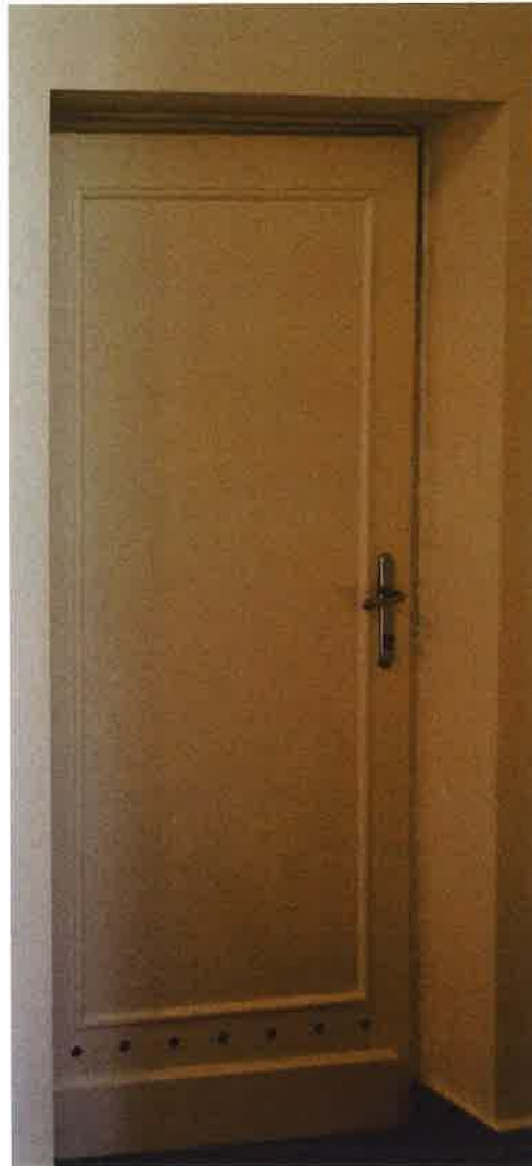
II. 99 Oryginalne drzwi do pomieszczenia technicznego
