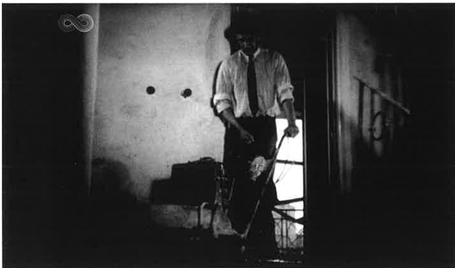
Il. 32 Przykładowe wnętrze klatki schodowej na MDM w trakcie prac, kadr z PKF 31/51, 00:00:00:12, Filmoteka Narodowa
