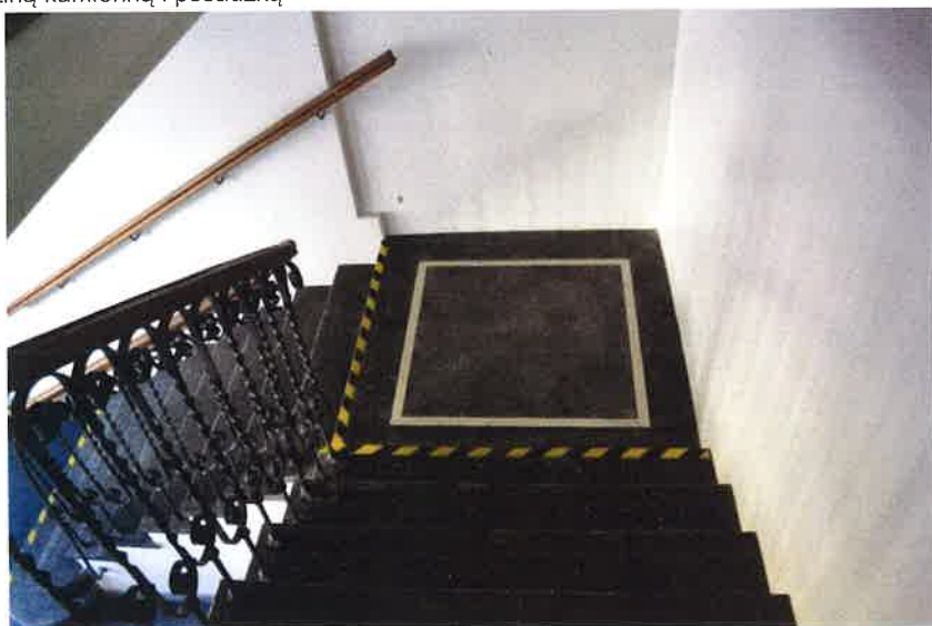
II. 87 Wnętrze d. baru mięsnego - biblioteka, klatka schodowa, lastrykowe schody
