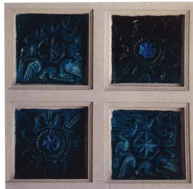
II. 77 Ceramiczne kasetony szkliwione na kolor turkusowy, zróżnicowanie barwne wynika z charakteru szkliwa; 2 typy płytek
