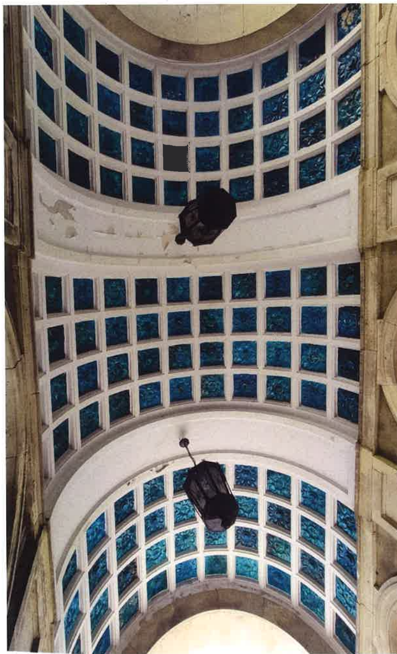
II. 76 Łącznik północny, ceramiczne kasetony w środkowym przęśle
