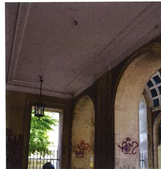
II. 78 Boczne (południowe) przęsło łącznika północnego o płaskim sklepieniu
