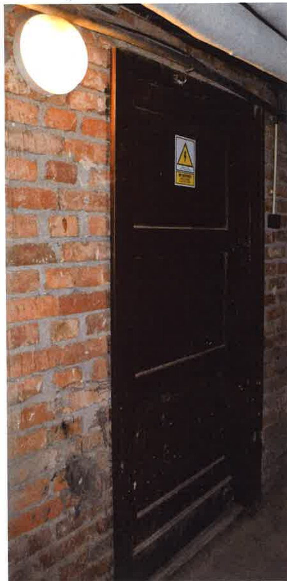
II. 102 Drzwi wejściowe do komórki piwnicznej
