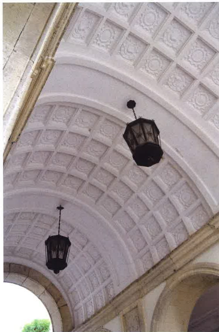
II. 1 Łącznik południowy widok na sklepienie środkowej nawy, kasetony pomalowane na biało, na gurtach oryginalne latarnie
